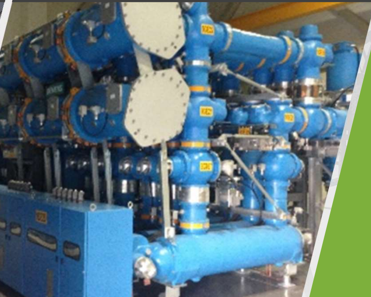
SUBESTACIONES ENCAPSULADAS
